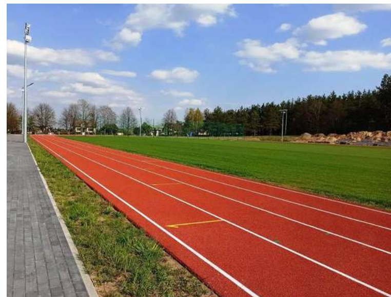
Nowo wyremontowany stadion w Jednorożcu - fragment boiska i bieżnia, w tle trwające prace nad budową trybun
