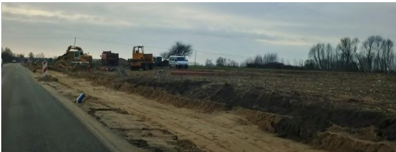
Nowo powstająca ścieżka rowerowa pomiędzy Przasnyszem a Leszmem.
