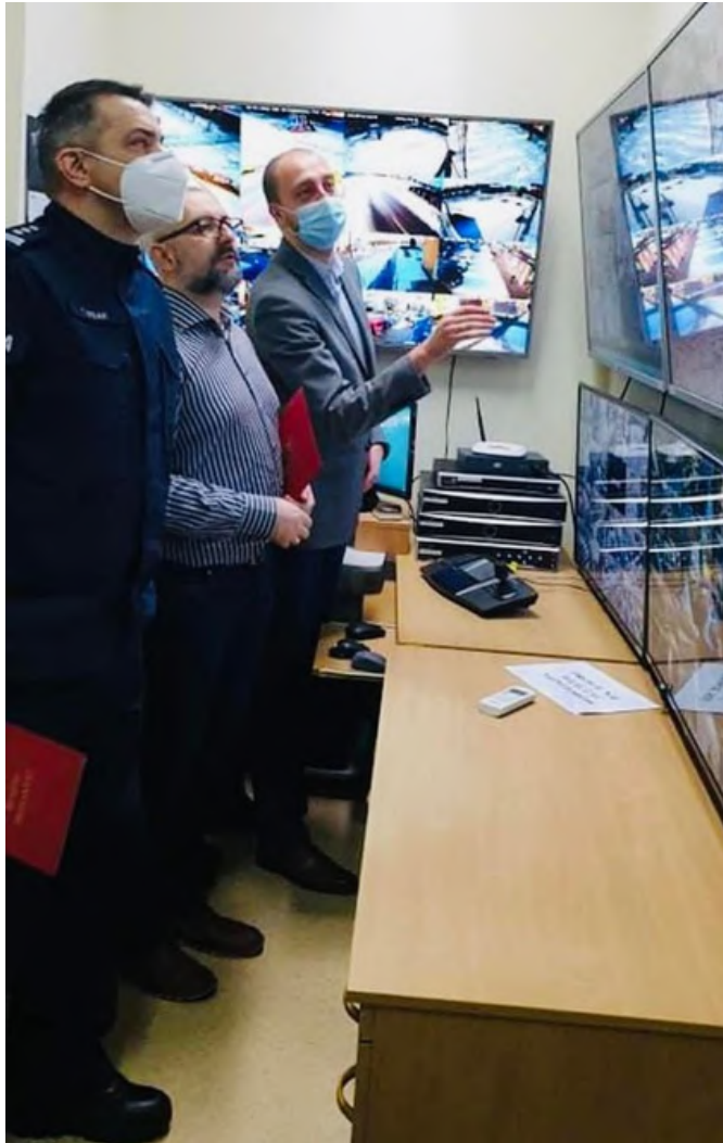
Nowe kamery zostały zamontowane na trasach wjazdowych do Przasnysza.
