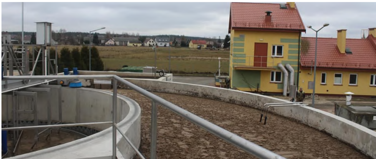
Zmodernizowana oczyszczalnia ścieków w Jednorożcu przy ulicy Zielonej.
