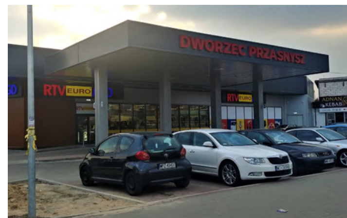
Tak prezentuje się dworzec autobusowy w Przasnyszu po remoncie.
