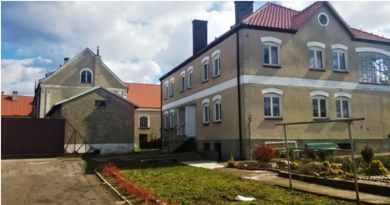
Budynki kompleksu klasztornej Klarysek Kapucynek (pierwotnie Bernardynek) w trakcie oczekiwania na niezbędne prace remontowe.
