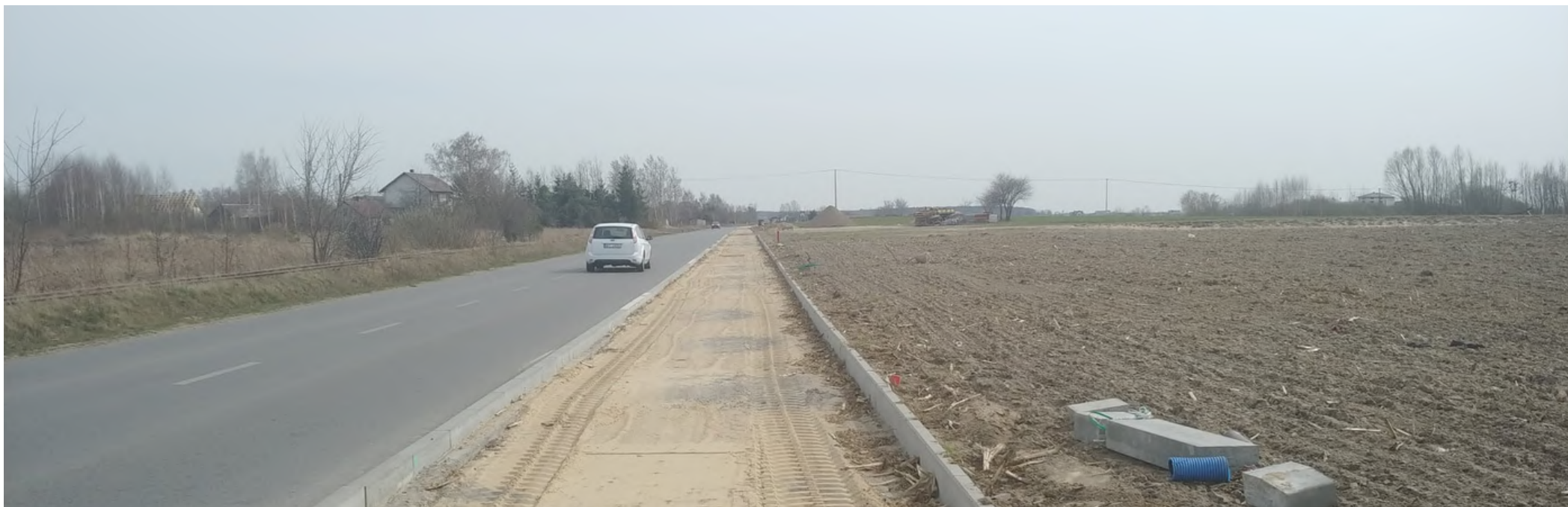
Trwa budowa ścieżki pieszo-rowerowej z Przasnysza do Leszna i Gostkowa.
