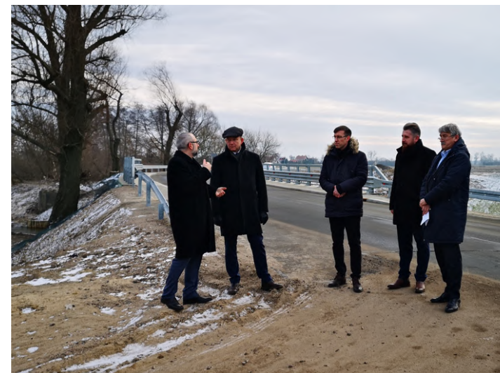
Prezentacja przebudowanego mostu w Obrąbie. Inwestycja dofinansowana dwoma milionami złotych ze środków rządowych.
